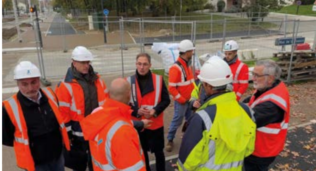
Sur le chantier du boulevard Michel-Miserey
