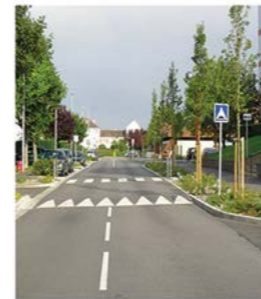
Square du Mâconnais
